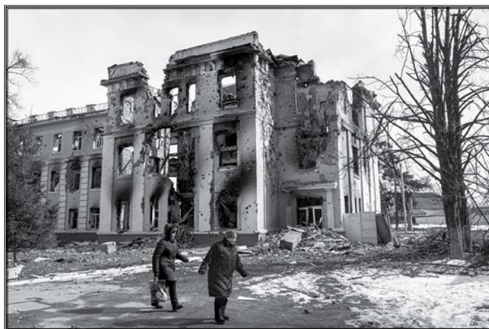
Зруйнована будівля школи, м. Харків, 2022
